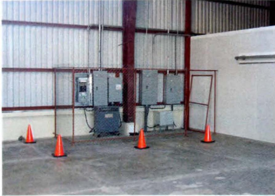
Figura A2.7: Durante la etapa de implementación del Sistema de Gestión de las BPM se corrigieron los peligros potenciales observados en la figura A2.6.
