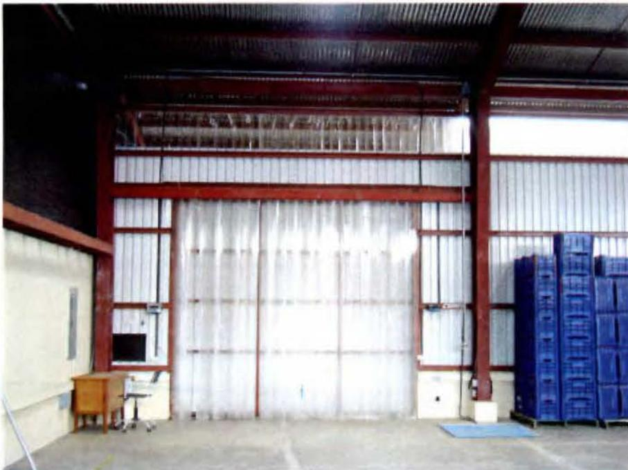
Figura A2.8: En esta figura se observa que en la planta se carecía de equipos para el control de plagas, además de que no se mantenía espacio para inspección entre el material estibado y las paredes.
