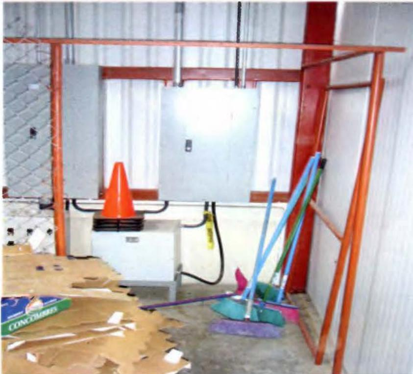
Figura A2.6: Situación de peligro encontrada durante la auditoría, en la zona de los paneles de distribución eléctrica se almacenaban materiales y equipos.
