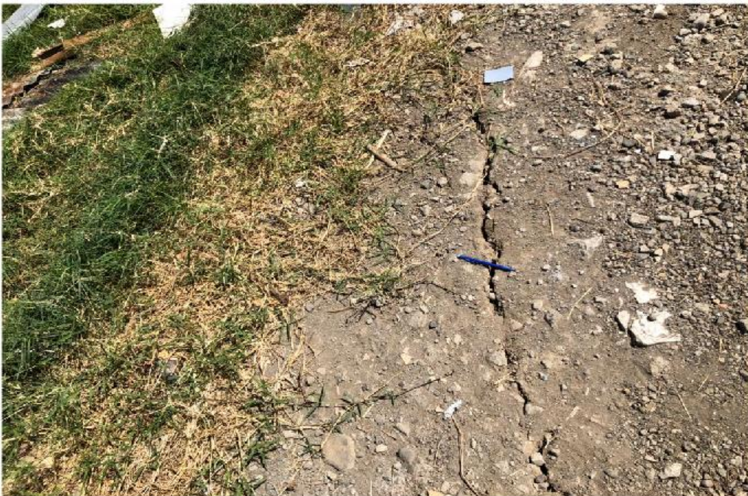
Figura 51. Agrietamiento en el terreno, indicio de deslizamiento.
