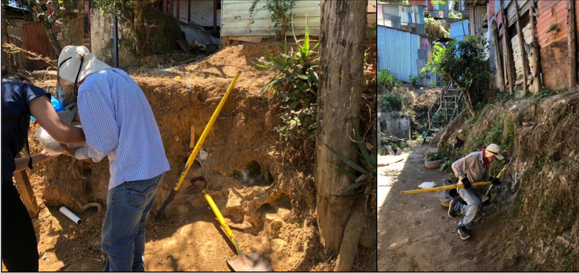
Figura 17. Recolección de muestras de suelo para ensayos de laboratorio.
