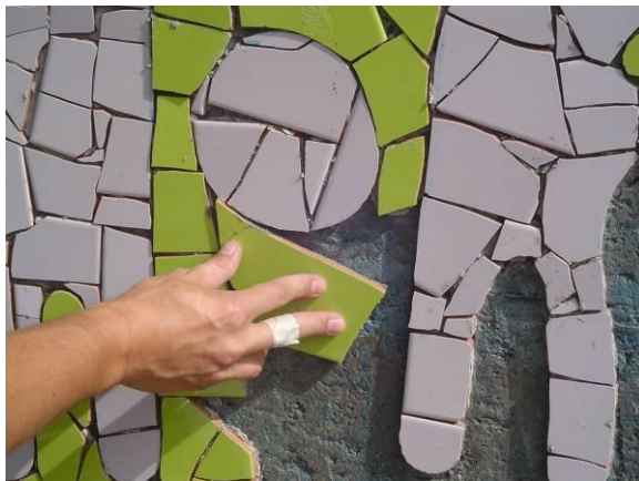
Figura 17. Se dispone cada pieza sobre la pared.
