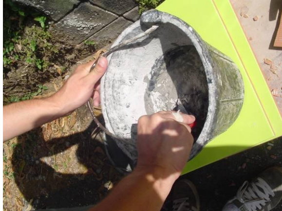
Figura 15. Se prepara la mezcla.
