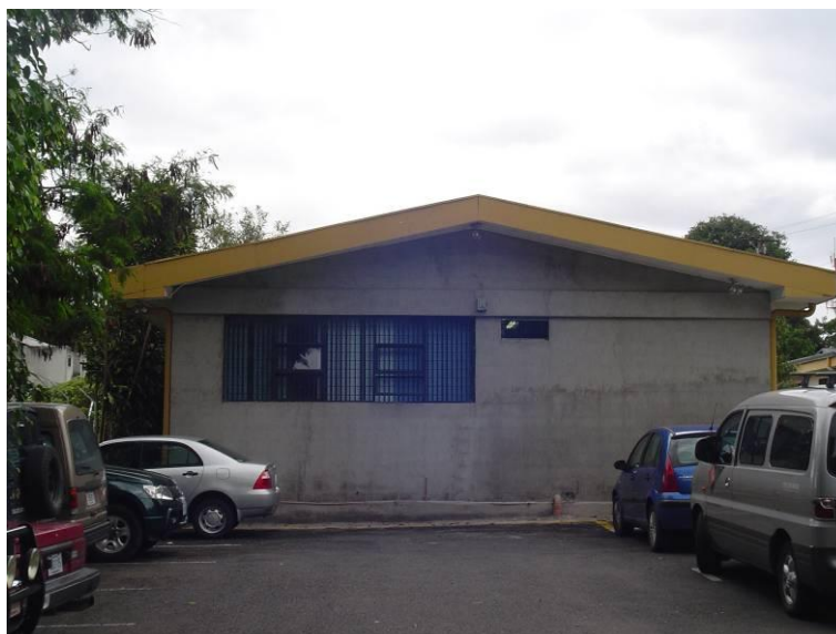
Figura 1. Vista Frontal de la pared.
