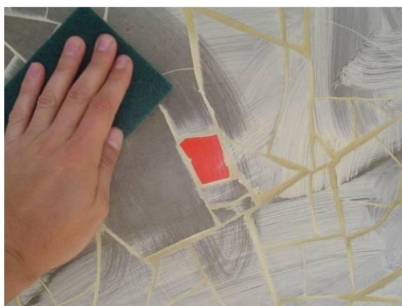
Figura 21. Limpieza del material en seco.
