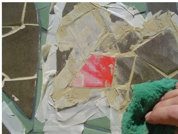
Figura 20. Limpieza del exceso de mezcla.
