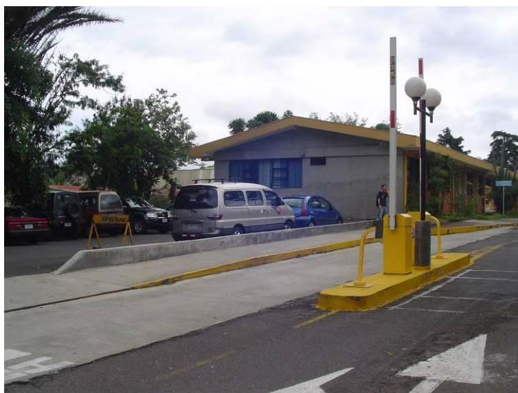
Figura 2. Vista desde la vía pública.
