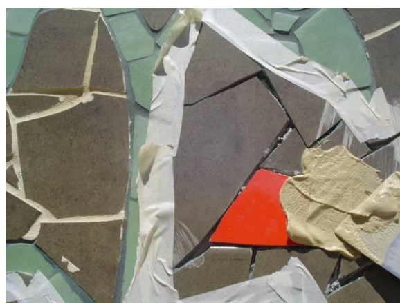
Figura 19. Aplicación de la fragua.
