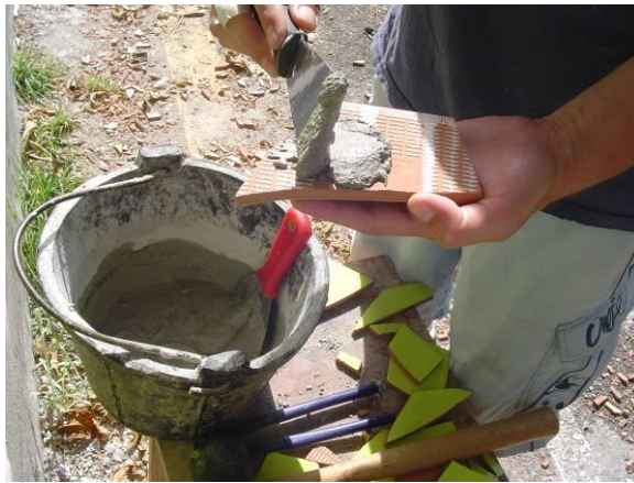
Figura 16. Se aplica la mezcla sobre la pieza.
