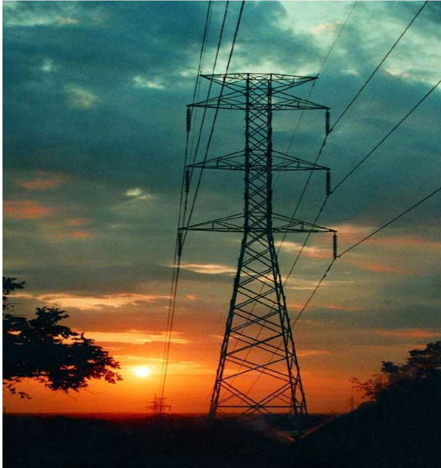
Torre de transmisión doble circuito, doble hilo guarda, 230 kV
