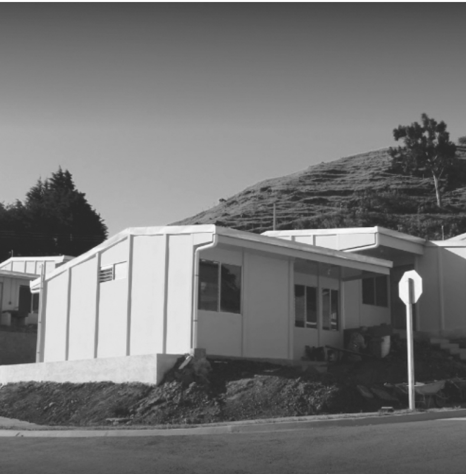
Figura 20. Fotografía de Valle del Sol. Fuente: Fotografías del archivo del BANHVI.
