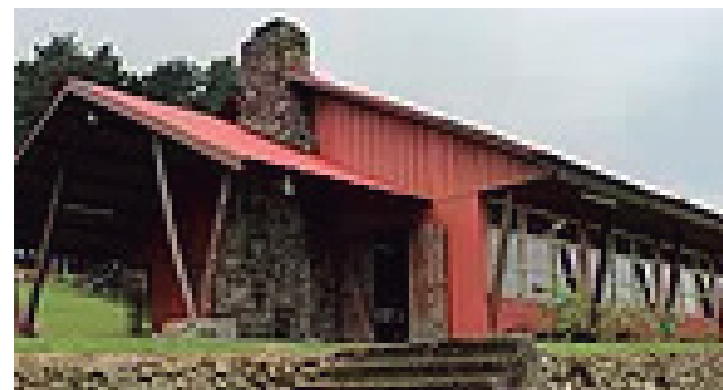
Imagen n°20.b. Instalaciones de Campamento Roble Alto Fuente: https://www.roblealto.com (2017)
