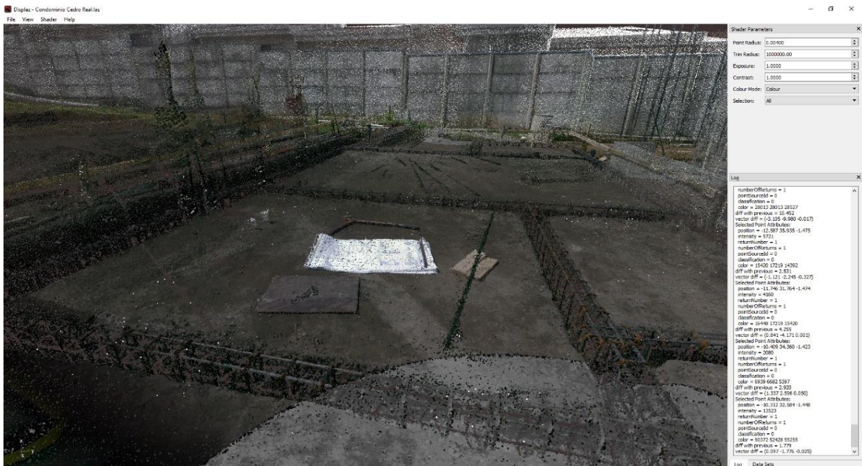
Figura 24. Nube de puntos de la etapa de colocación de acero de las cimentaciones
