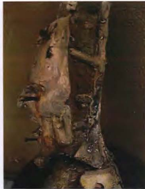
Imagen 37. Presencia de un agente oscuro en la colada madre del paquete
