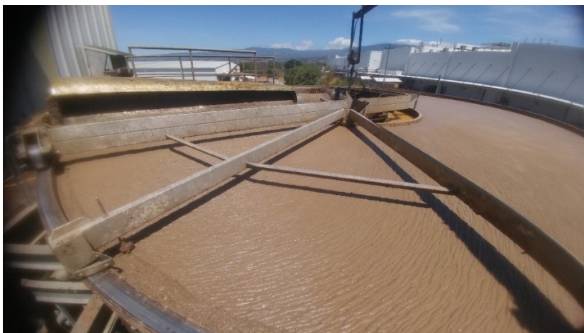
Figura 7.9. Floculación en el DAF con el tratamiento químico propuesto, 10 ppm de coagulante Q-180 y 8 ppm de floculante QAN-93 (fotografía tomada en Empaques Santa Ana el 06 de marzo del 2019).
