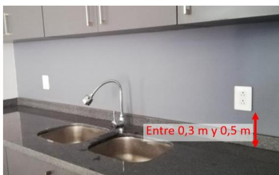
Figura 14. Altura de tomacorrientes sobre mesón de cocina
