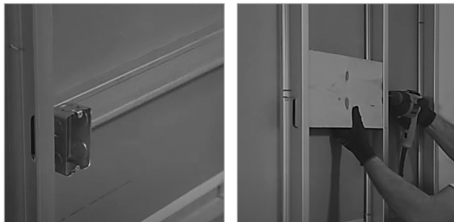
Figura 88. Instalación de refuerzos en paredes livianas
