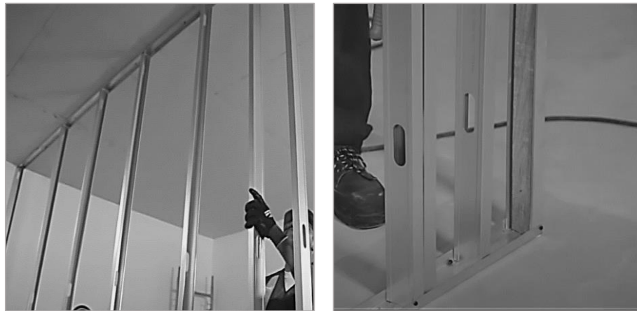
Figura 87. Instalación de postes de paredes livianas
