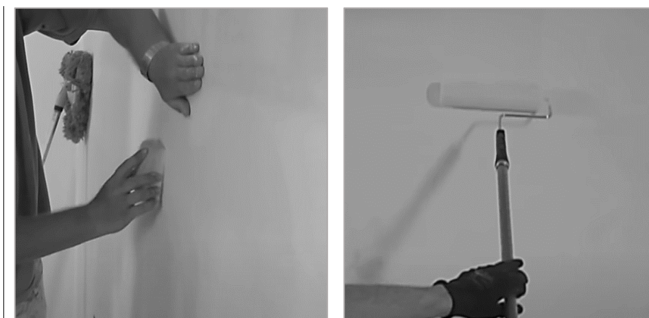
Figura 96. Lijado y pintura de paredes livianas
