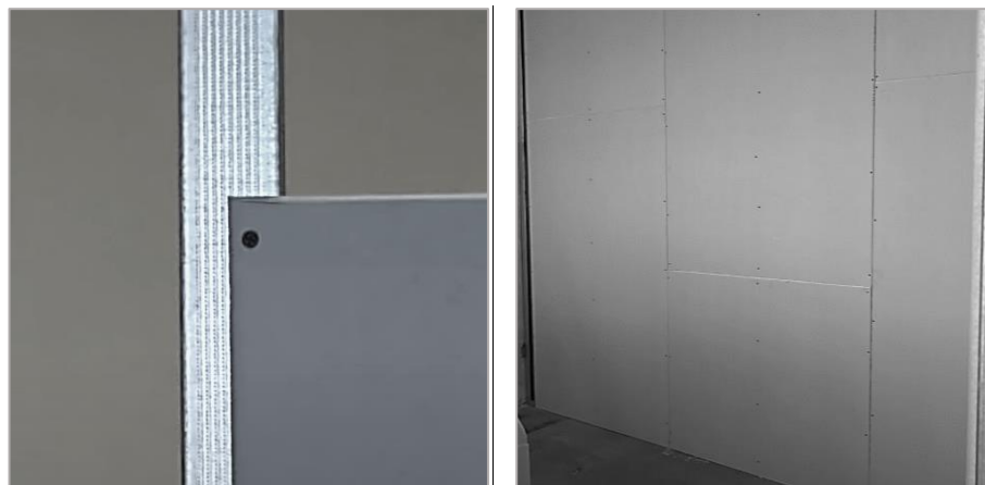
Figura 92. Instalación de las láminas
