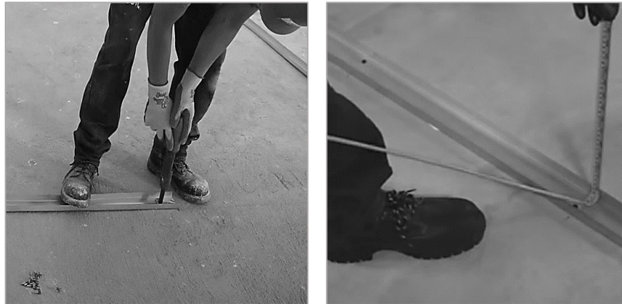
Figura 84. Instalación de los canales de paredes livianas
