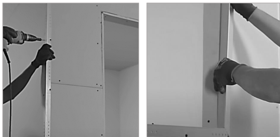
Figura 93. Instalación de esquineros
