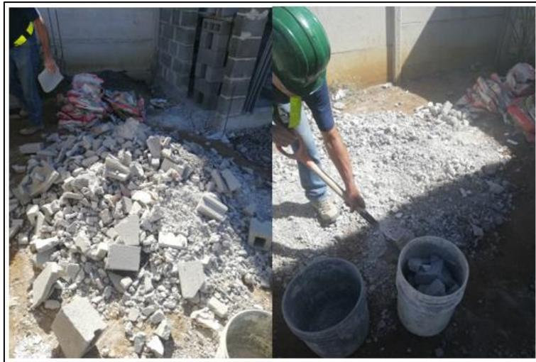
Figura 25. Separación de residuos de block del escombros.
