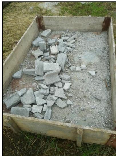
Figura 26. Separación de residuos de block del escombros.
