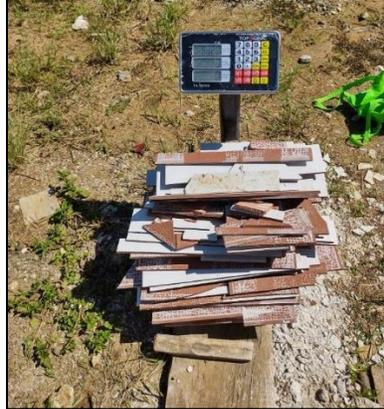
Figura 40. Residuos de revestimiento, proyecto 2B
