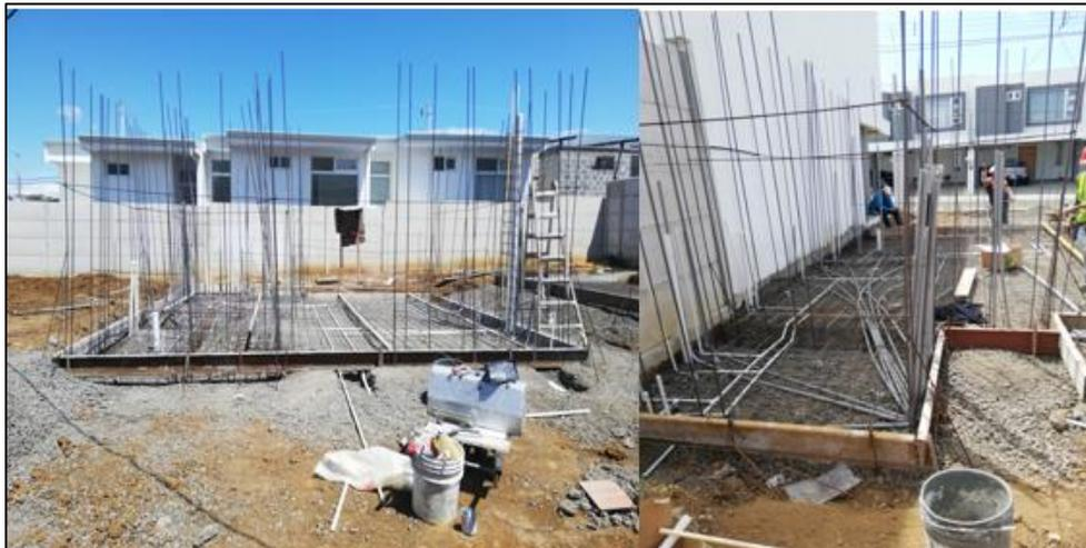
Figura 13. Losa flotante proyectos 1B y 1A, respectivamente.
