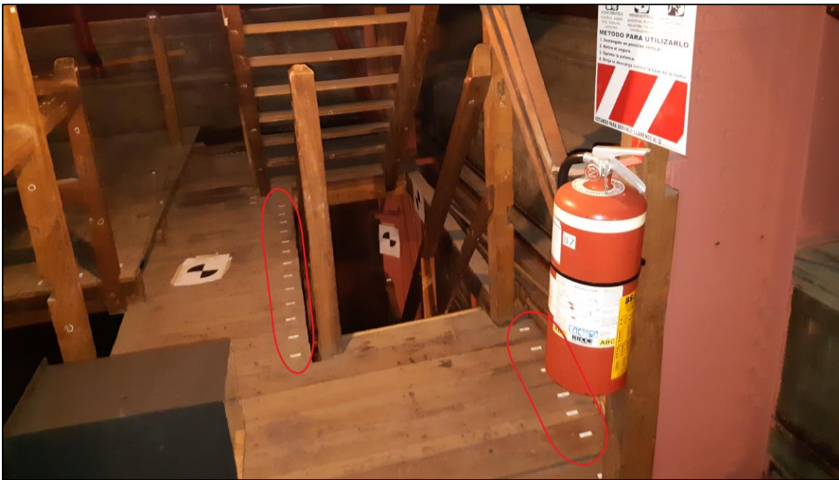
Figura 35. Fotografía de las etiquetas de la madera en sector de la tramoya Fuente: Murillo, 2020.
