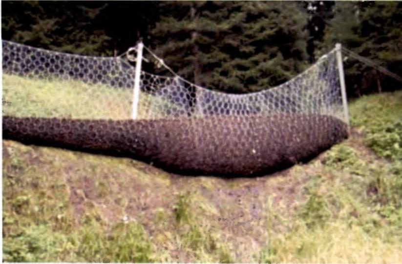
Figura 38. Ejemplo de barrera flexible para desprendimiento de materiales
