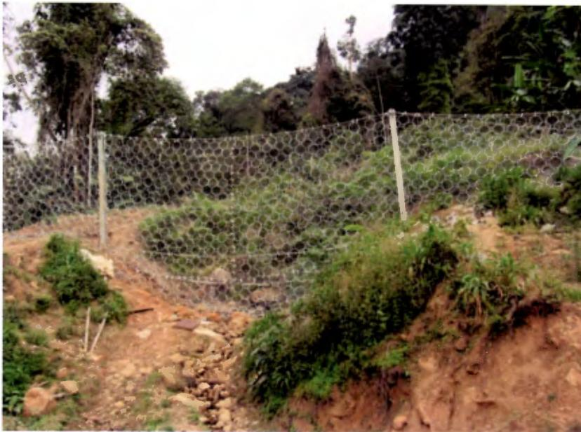
Figura 39. Barreras de protección fijas
