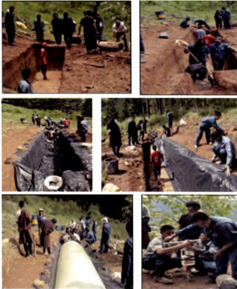
Figura 37. Proceso de construcción e instalación de un biodigestor
