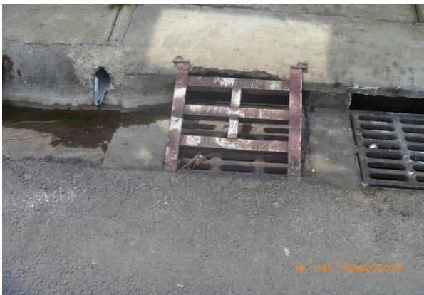
Figura 44 Rampas construidas en los caños
