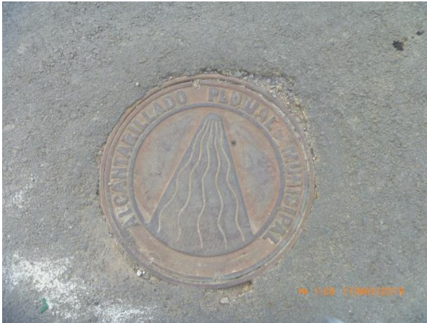
Figura 64 Tapa de pozo del alcantarillado pluvial del proyecto
