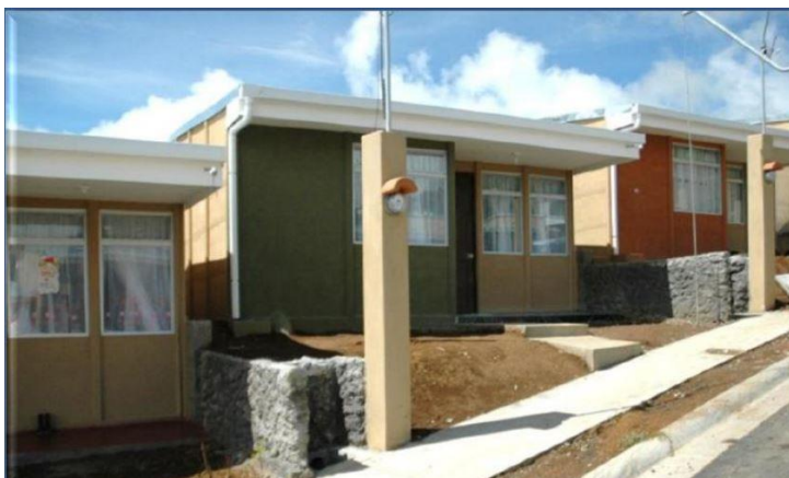
Figura 63 Muros de retención en las casas de la etapa I del proyecto
