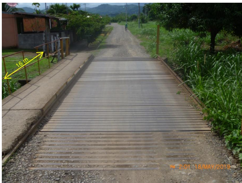
Figura 13 Medición realizada cerca del canal de riego
