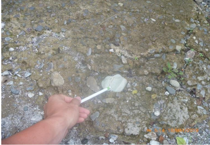
Figura 24 El agregado utilizado en algunas aceras no es el adecuado
