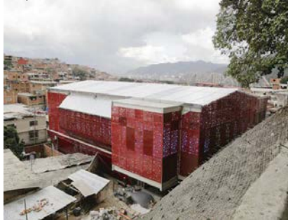
Imagen 45. Vista exterior, Polideportivo vertical Santa Ana. (2015). Fuente: http://www.ciudadccs.info/polideportivo-santa-ana/http://www.entodonoticias.com/tag/polideportivo
