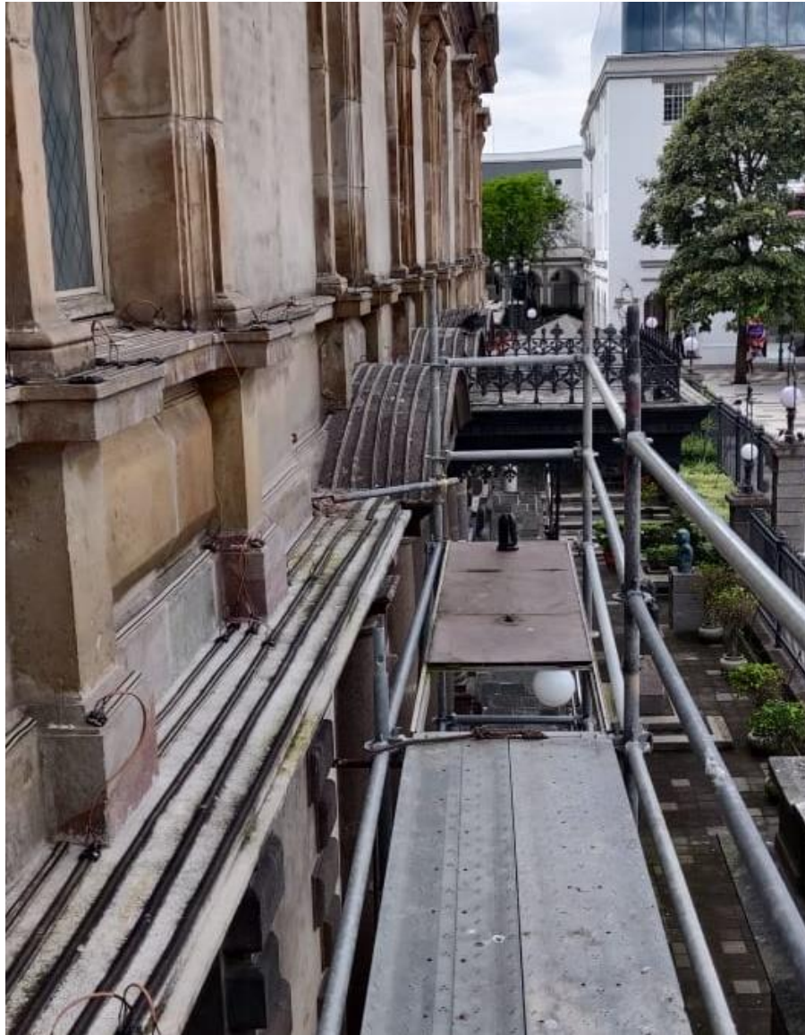
Figura 23. BLK 360 sobre andamio
