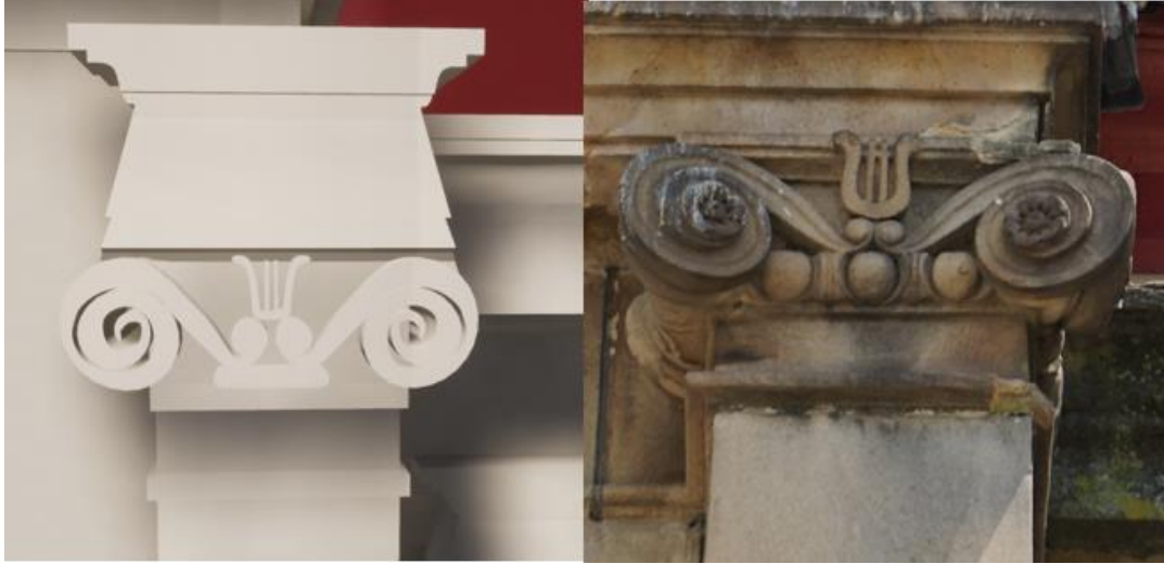
Figura 63. Diferencia de capitel entre modelo y pilastra original
