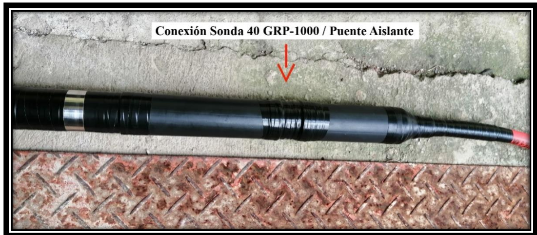
Fig. 30. Correcta protección en la conexión entre la sonda y el puente aislante.
