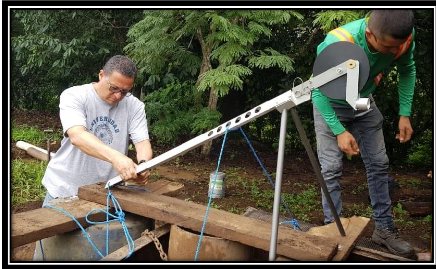
Fig. 57. Instalación del trípode y soporte del mismo.
