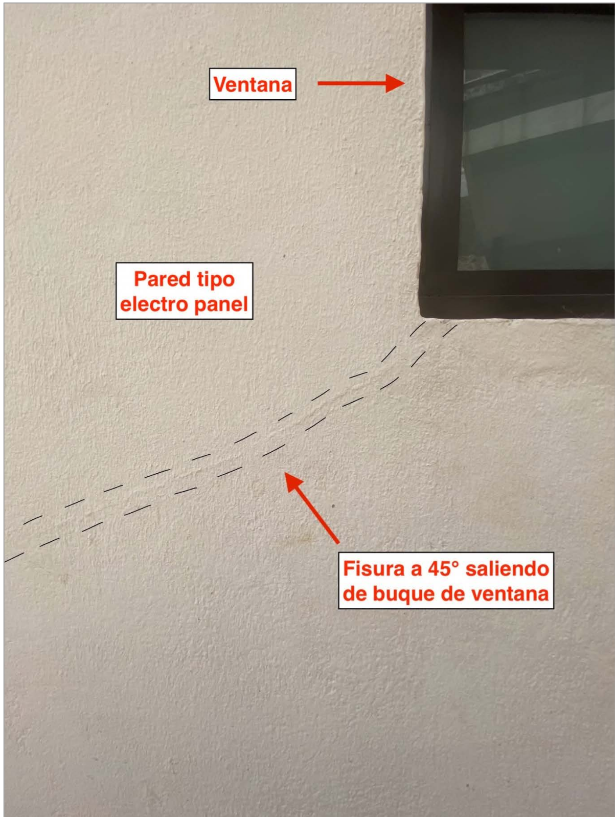
Figura 42. Muestra 1 de daño tipo 45B dentro de los objetos de estudio Fuente: Elaboración propia
