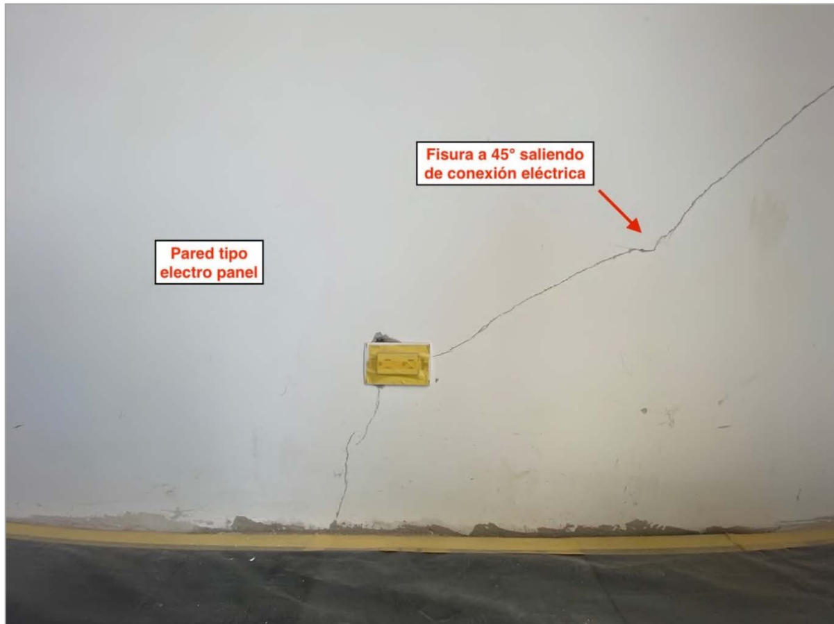
Figura 43. Muestra 2 de daño tipo 45B dentro de los objetos de estudio Fuente: Elaboración propia
