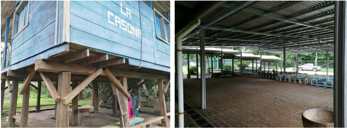
Figura 2.12. Fotos de “La Casona” y galerón en el centro educativo Ngäbegüe en La Casona. 42
