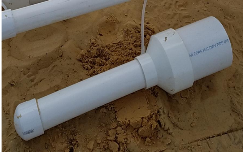
Figura 2. Lisímetro de drenaje para monitorear lixiviados en aguas subterráneas.
