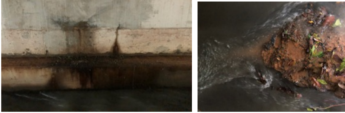
Figura 35. Condición interna del paso M4
