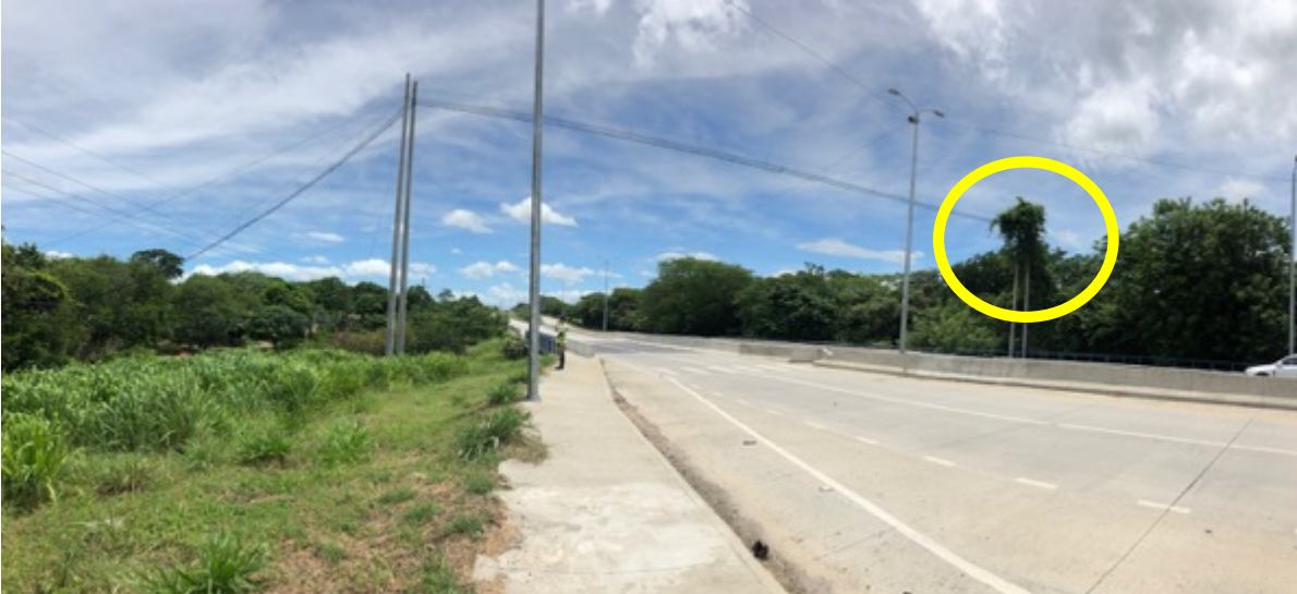
Figura 33. Paso A7 con presencia de conectividad en un extremo de la estructura
