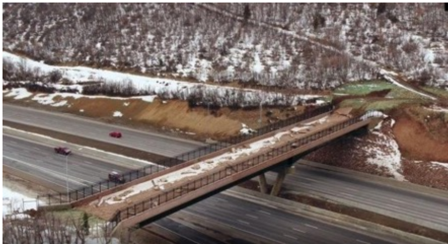
Figura 9. Paso superior en Park City, Utah USA Nota: Tomado de UDOT, 2018
