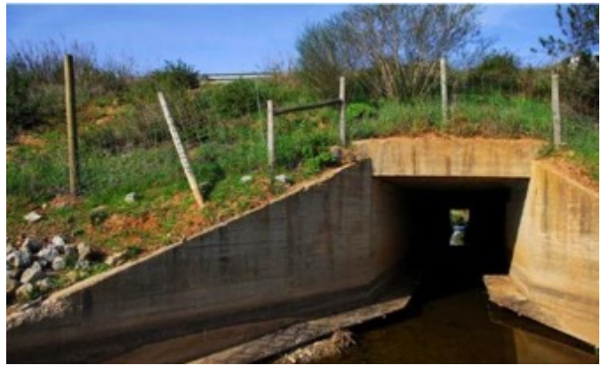
Figura 14. Drenaje adaptado con pasarelas secas de concreto para animales de pequeño tamaño en el sur de Portugal Nota: Tomado de: Joaquim Pedro Ferreira, n.d.
