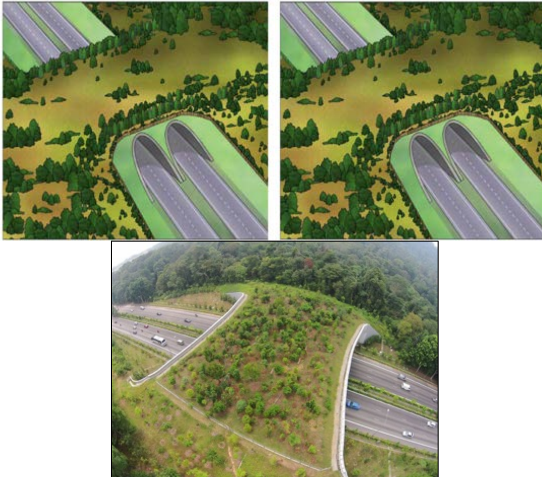
Figura 8. Esquema general de un ecoducto (A). Ejemplo de un ecoducto en Singapore, Eco-Link BKE (B) Nota: Tomado de MAGRAMA, 2015 (A). Chew Hui Min, 2015 (B).
