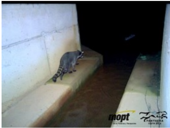
Figura 13. Drenaje adaptado con pasarelas secas de concreto en la Ruta N°4, Costa Rica Nota: Tomado de MOPT, 2018
