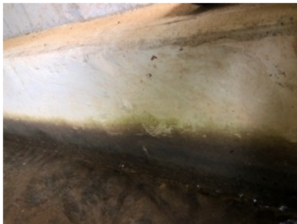
Figura 34. Condición interna lateral de las pasarelas
