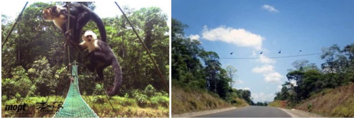
Figura 7. Paso de puente de malla en la Ruta Nacional N° 4, Costa Rica.
