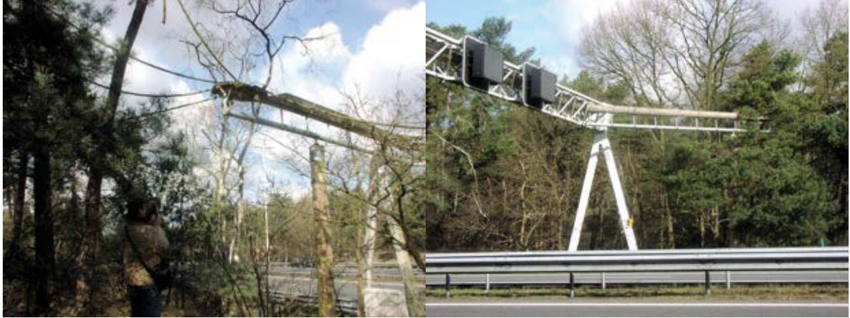
Figura 6. Plataforma instalada en el soporte de señalización para el paso de fauna y extendiéndose a cuerdas sujetas a árboles.
