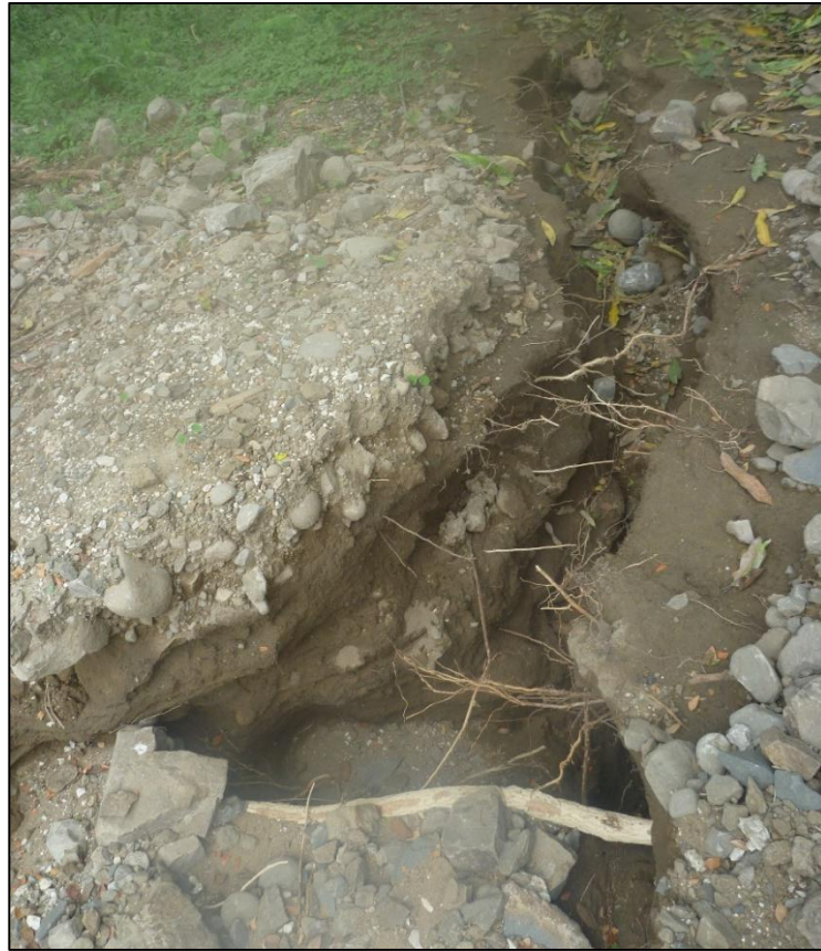
Figura 3-6. Erosión en surcos en la cuenca del río Abangares
