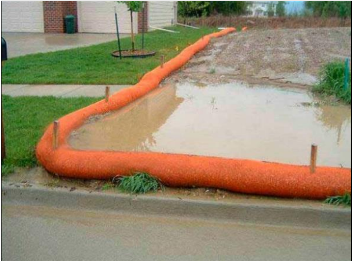
Figura B-4. Media filtrante de compost en entorno urbano Fuente: (Erosion Control Products, 2021)
