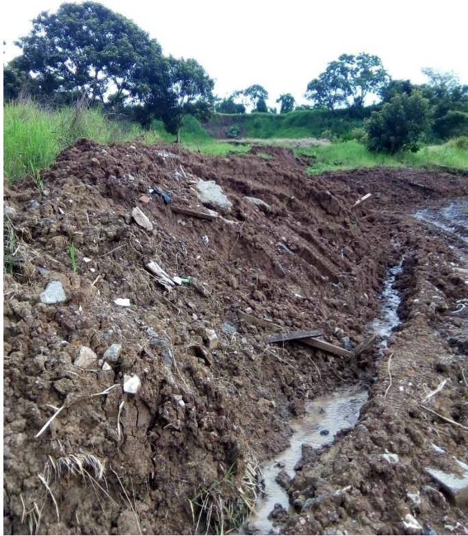
Tierra acumulada producto de los deslizamientos.
