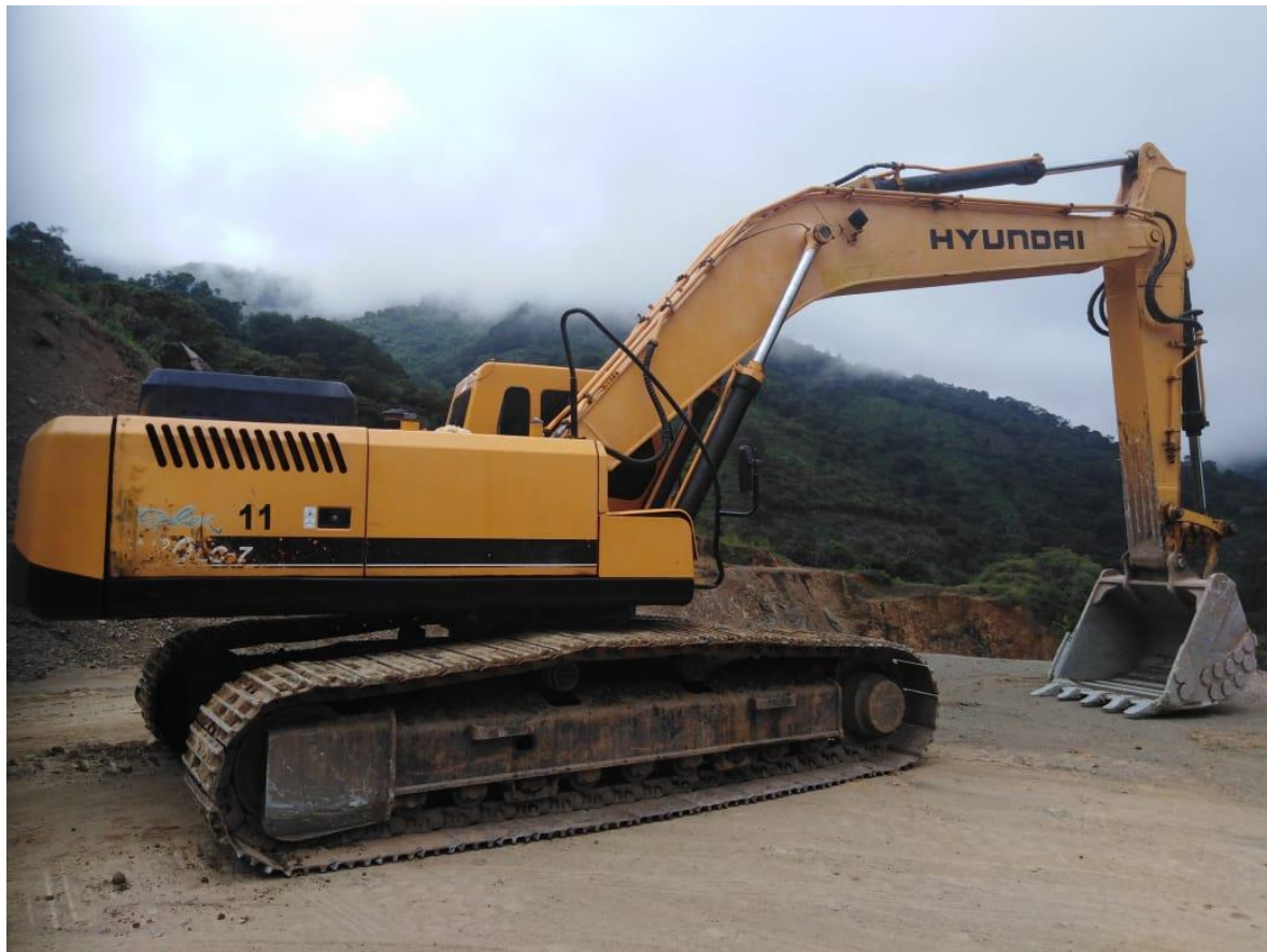
Figura 4: Ejemplo de maquinaria utilizada para recoger el material.
