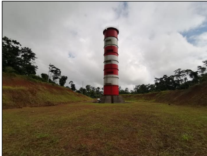
Ilustración 3.12. Tanque de Oscilación de la PHLNII. Fuente: Autores.
