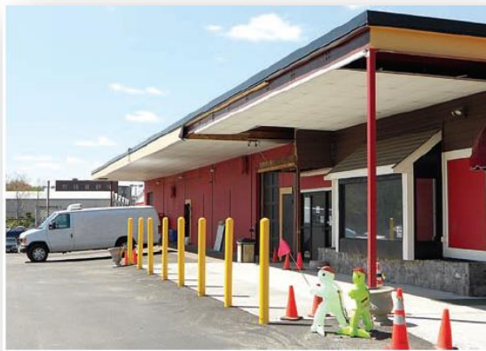
Ilustración 2.6 Anden de carga exterior.
