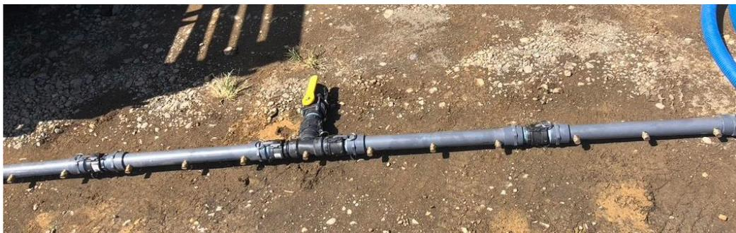
Figura 39. Barra distribidora con boquillas de salida plana
