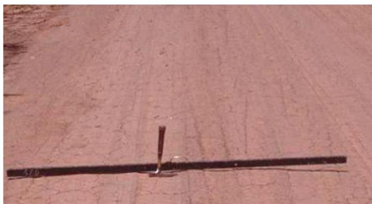
Figura 17. Camino estabilizado con enzimas
