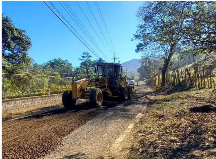
Figura 53. Conformación de la superficie en la RN 901
