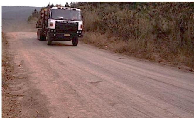
Figura 16. Camino estabilizado con estabilizadores líquidos de alta acidez
