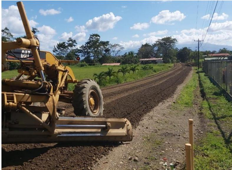
Figura 38. Conformación de la superficie en la RN 749
