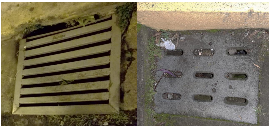
Figura 61. Rejas con área de orificios reducida
