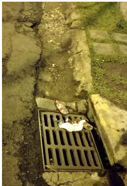
Figura 2. Sección de cordón y caño con cambios en la geometría y rugosidad.
