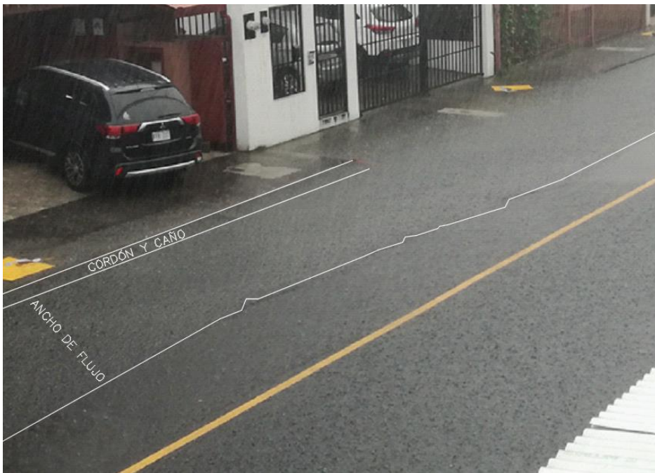
Figura 48. Acumulación de flujo en cordón y caño
