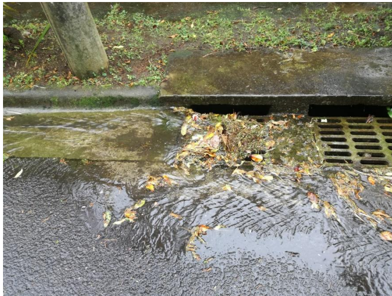
Figura 60. Pérdida de eficiencia por obstrucción en la reja
