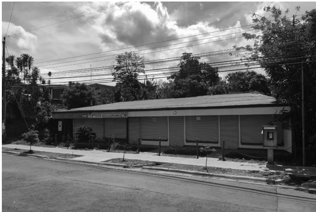
Imagen 4.7 "Locales comerciales en el terreno." Villalobos Rodríguez, A. (2019)
