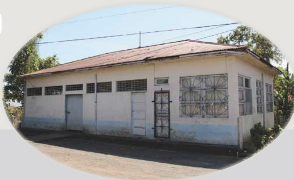
Imagen 056. Oficina - Almacén Fuente: Propia, 2018.
