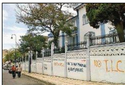
Figura 18. Fotografía del muro de la Asamblea Legislativa. 11 de abril, 2007. Recuperada de http://www.aldia.cr
