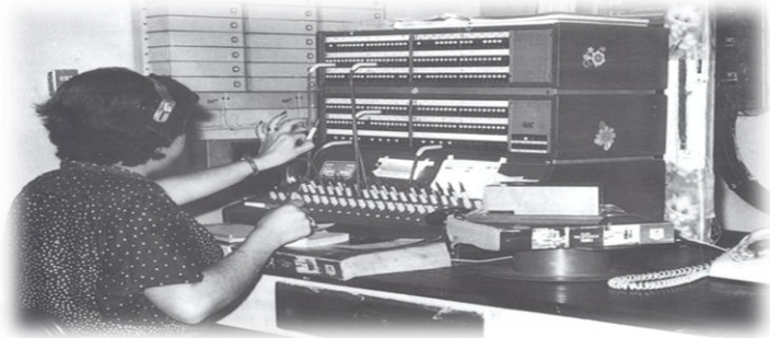
Fotografía N°.2. Operadora ante Central manual de 200 líneas (1960).
