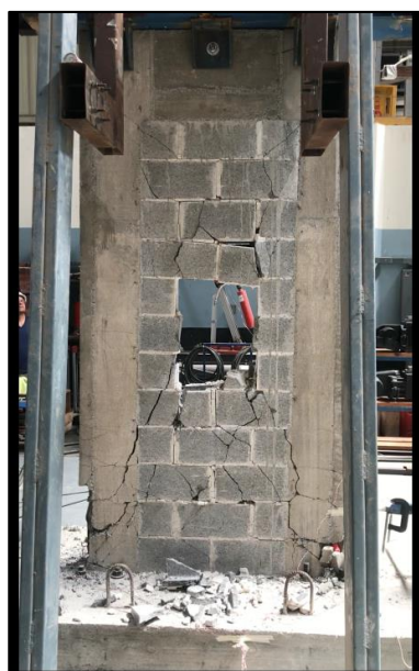
Figura 66. Estado final Muro RA2.
