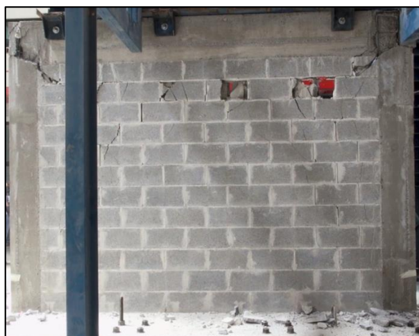
Figura 53. Estado final del Muro RA.75.
