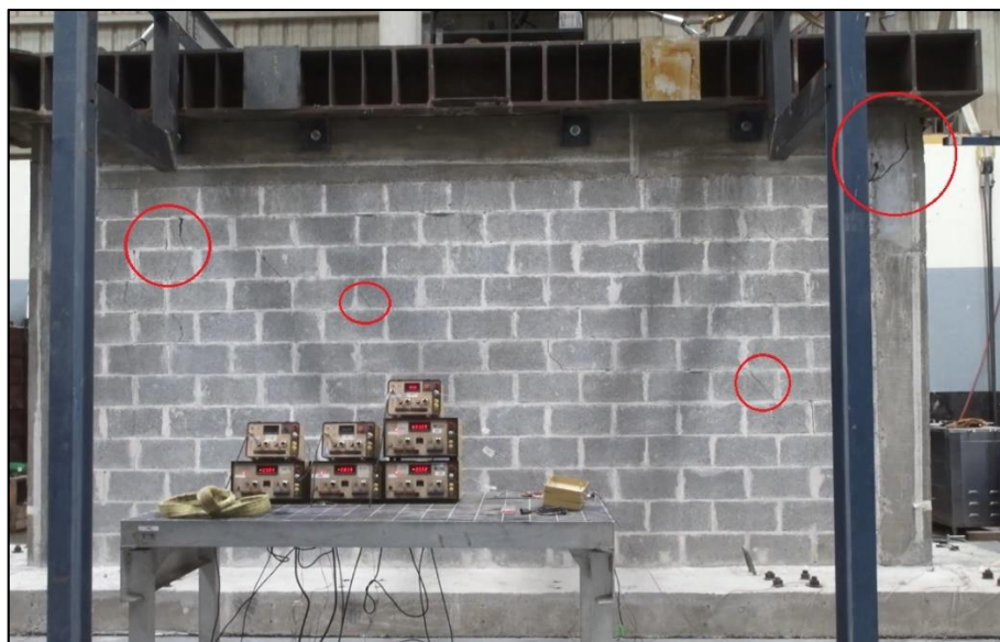
Figura 48. Muro RA.5 agrietado desplazamiento \pm 52 mm.
