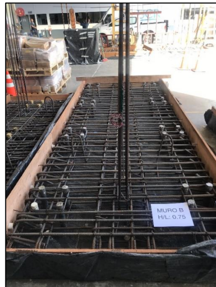
Figura 31. Encofrado de armadura de cimentación.
