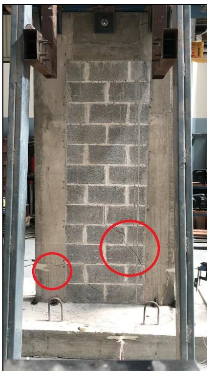
Figura 65. Muro RA2 agrietado al alcanzar a la capacidad máxima.
