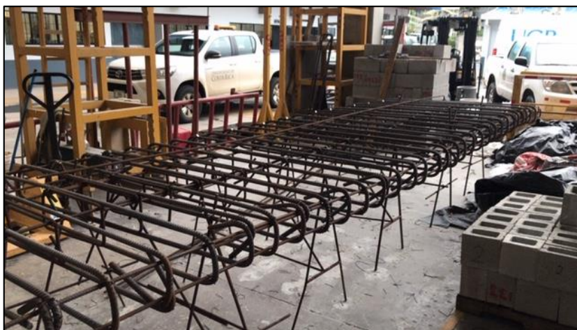
Figura 28. Armadura de cimentación en proceso de construcción.
