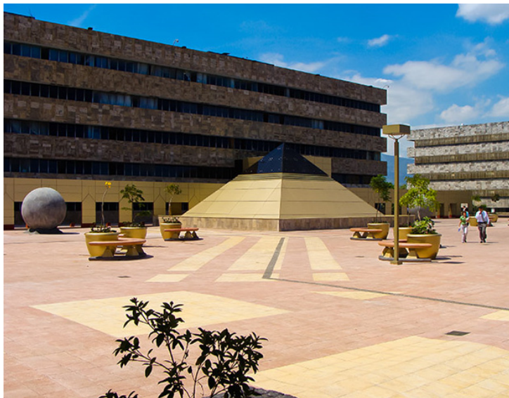
Figura 43: Plaza de la Justicia. Fuente: Constructora Navarro y Áviles http://navarroyaviles.com/es/proyectos/oficinas/
