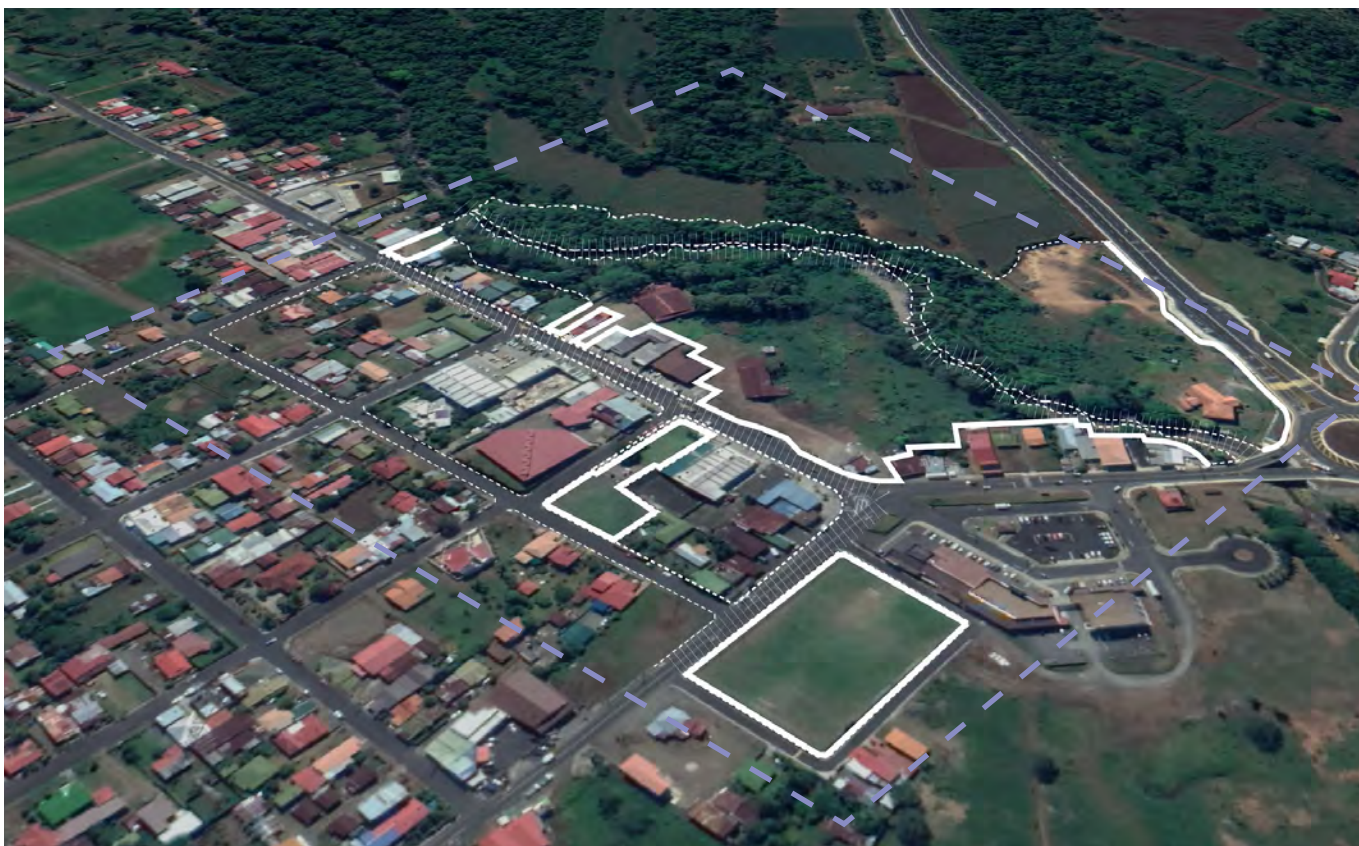
↑ f3.10 - Vista aérea de la zona de trabajo. Imagen tomada de Google Earth. (Mayo 2019).
