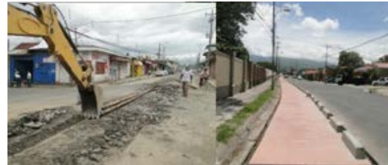
IMAGEN 3 . Construcción de la ciclo vía de Cartago, Recuperado en: http://www.crhoy.com/archivo/construccion-de-ciclovía-y-trocha-ferrea-en-cartago/nacionales
