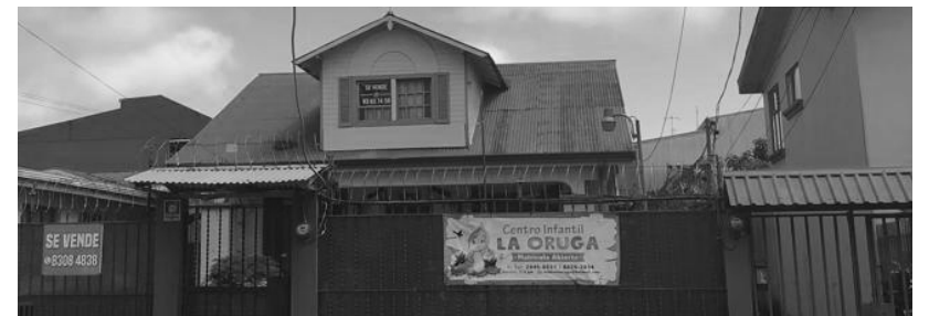
Imagen 10: Fotografía Cambio de Uso 1. Fuente: Rodríguez Villalobos, A. (2018)
