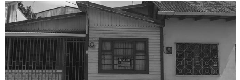
Imagen 9: Fotografía Cambio de Uso 1. Fuente: Rodríguez Villalobos, A. (2018)
