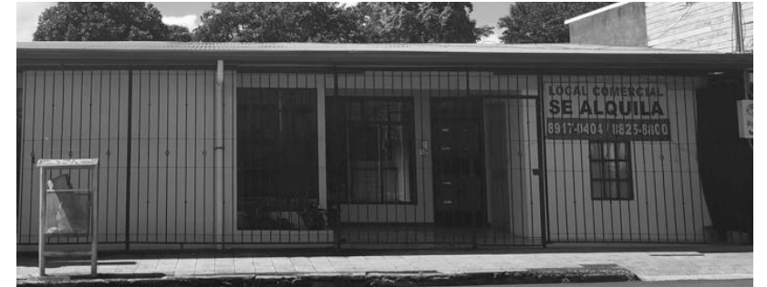
Imagen 8: Fotografía Cambio de Uso 1. Fuente: Rodríguez Villalobos, A. (2018)
