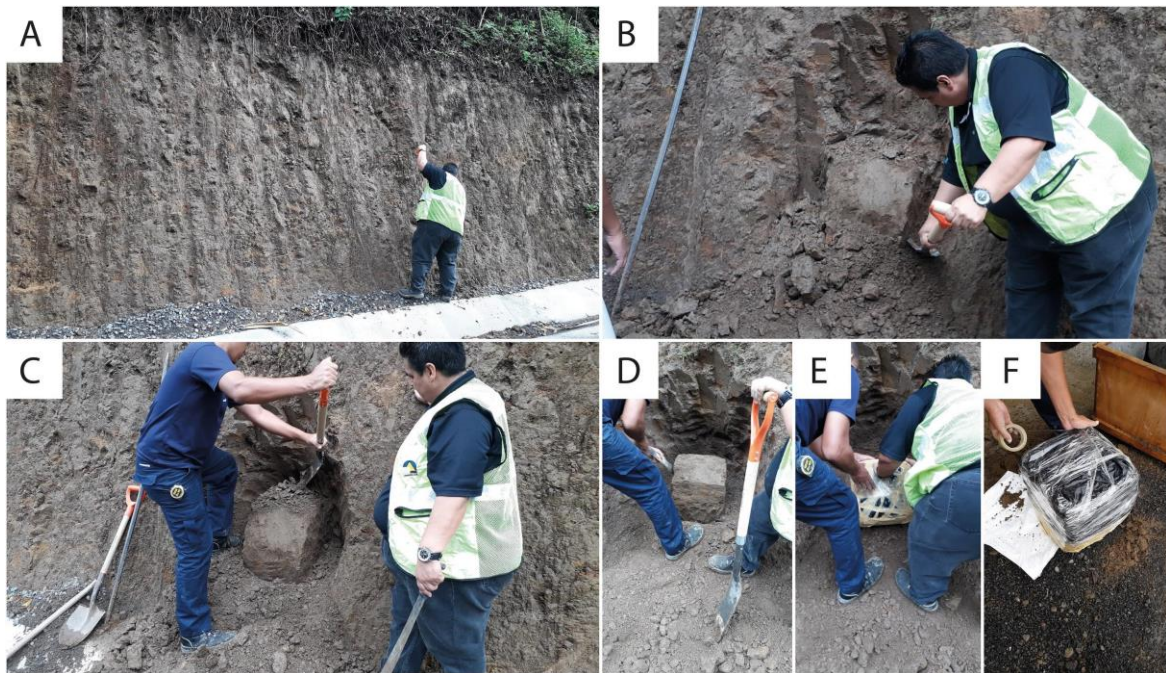
Figura 6.4: Proceso para extraer una muestra inalterada de suelo de uno de los taludes visitados. El proceso de extracción fue realizado por los técnicos del Laboratorio de Geotecnia del LanammeUCR. El objetivo de la muestra es poder obtener suelo que no haya sido sometido a la fuerzas de fricción, compresión, tensión, etc a causa del transporte o moldeado del bloque.
