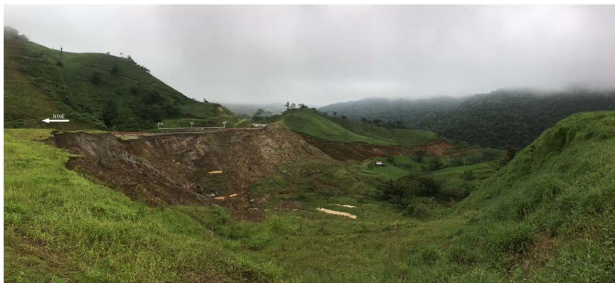
Figura 50: Deslizamiento del kilómetro 21.
