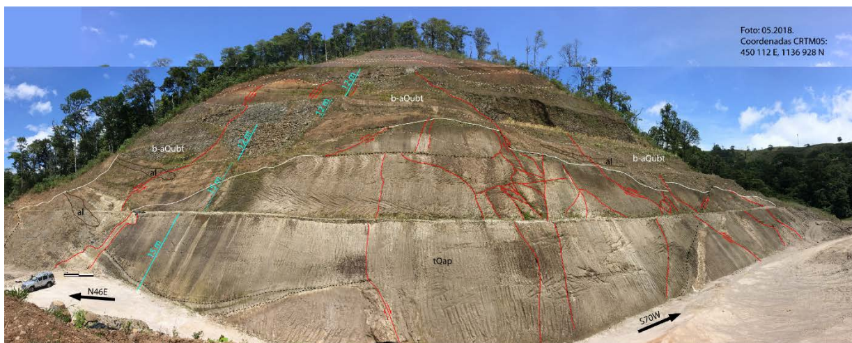
Figura 31: Interpretación del talud en el km 31.
