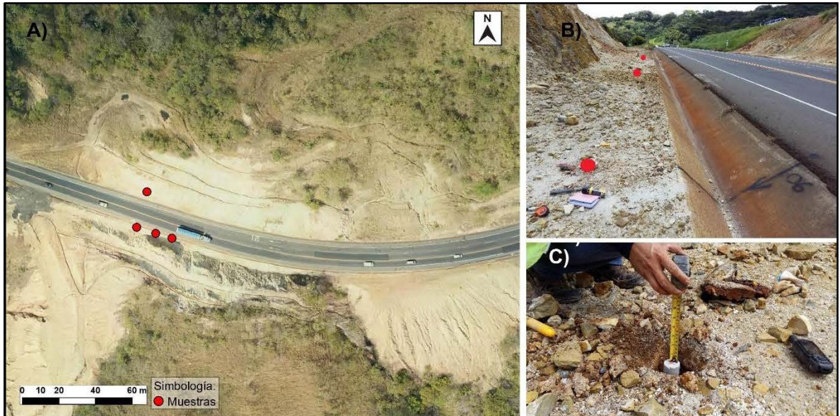
Figura 18. A) Fotografía área del estacionamiento km 48+000. B) Sitio de colocación de muestras en el talud izquierdo. C) Proceso de colocación de muestras. Los puntos rojos son los sitios donde se enterraron las muestras.
