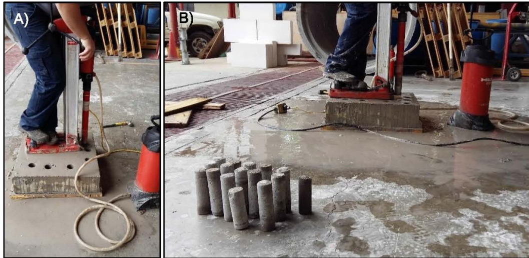
Figura 12. A) Extractor de núcleos, HILTI DD130 con broca de 2 pulgadas. B) Núcleos extraídos del panel con diferentes longitudes.
