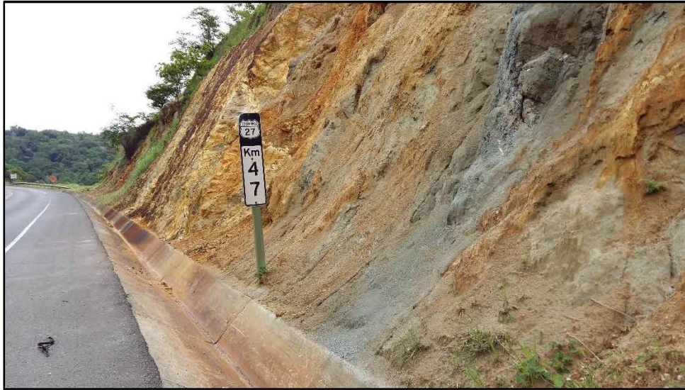
Figura 7. Talud izquierdo, estacionamiento km 47+000.
