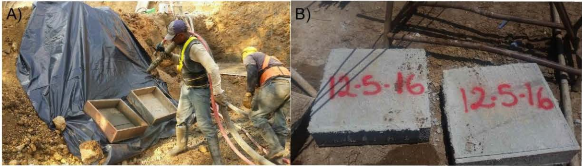
Figura 11. A) Proyección de concreto por parte de la empresa Geointer. B) paneles de concreto lanzado finalizados.
