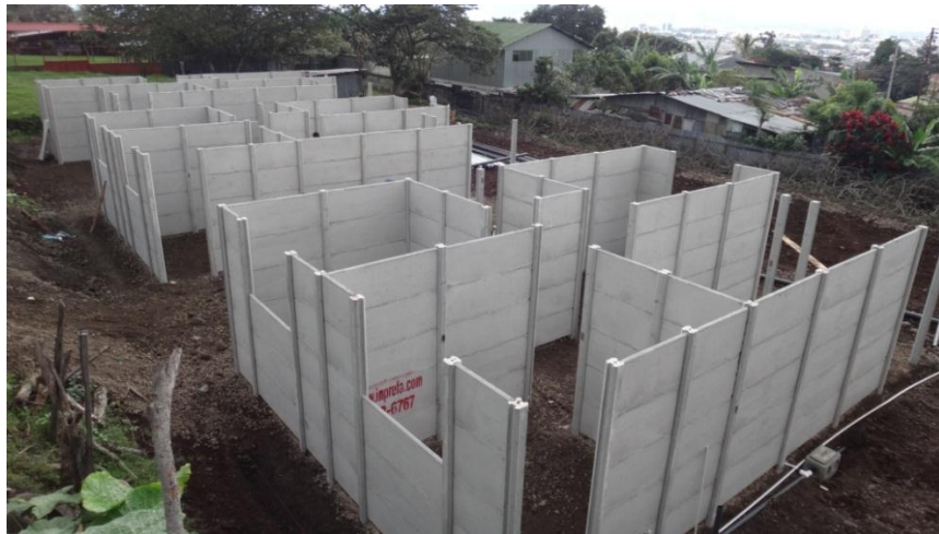
Figura 1. Sistema de construcción de columnas y baldosas de concreto prefabricado
