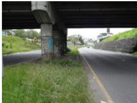
Figura 96. Bases paso elevado RN 204
