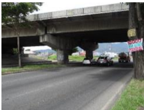
Figura 94. Bases paso elevado RN 204
