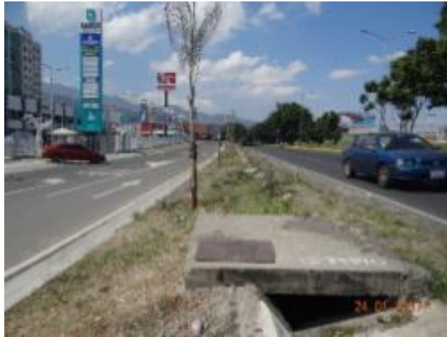
Figura 79. Condición margen sur tramo K-L
