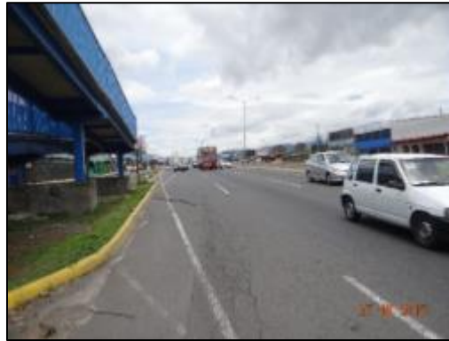
Figura 93. Bases de puente peatonal en margen sin resguardar
