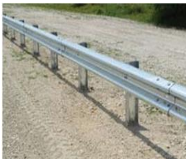
Figura 2. Ejemplo de barrera semirrígida
