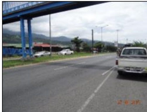
Figura 92. Bases de puente peatonal en mediana sin resguardar
