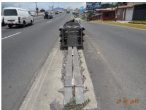
Figura 89. Estado amortiguador oeste paso elevado Alajuelita
