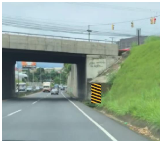
Figura 56. Demarcación retroreflectiva propuesta boulevard Rohrmoser
