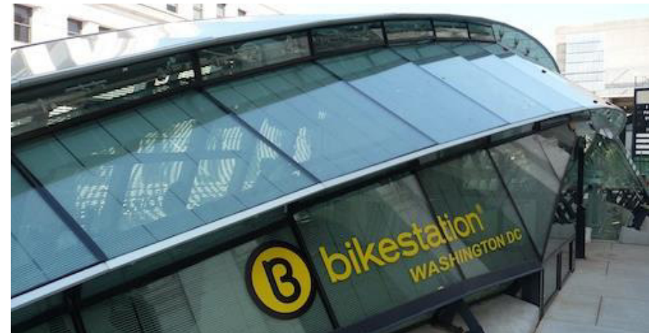
Imagen 85. Bikestation en California. Recuperado de http://www.yorokobu.es/bikestation-estaciones-de-servicio-para-el-ciclismo-urbano/
