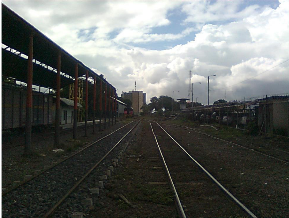
Imagen 203. Espacio vacío Estación al Atlántico en San José. Recuperado de http://crtrenes.blogspot.com/2011/10/patios-y-talleres-ferroviarios.html
