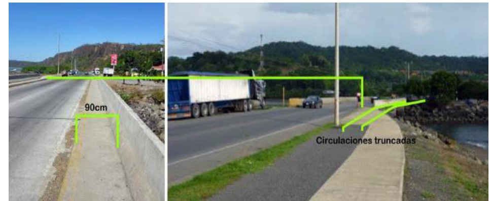
Imagen 45. Barreras, Ciclovia Caldera. Recuperado de Estudio del impacto de Ciclovías en Costa Rica. p. 33.
