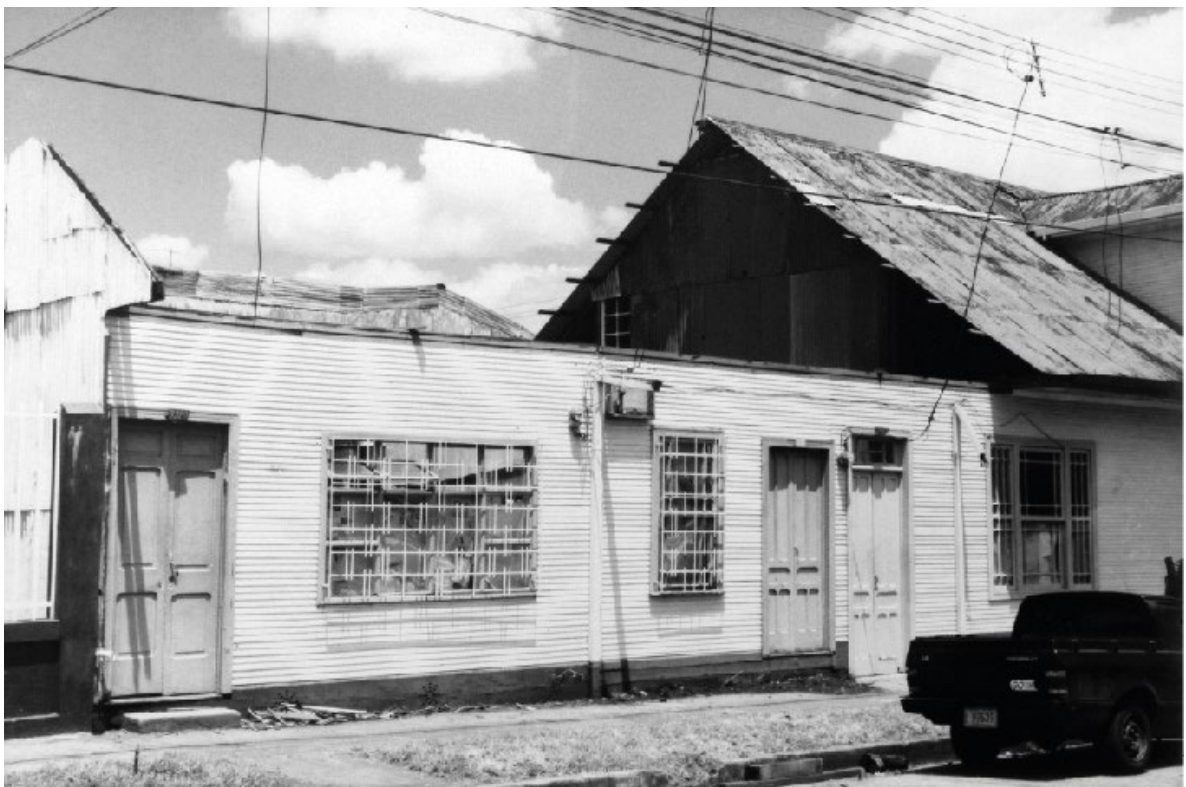
Fotografía de una casa de habitación por demolerse, ubicada en Barrio Escalante (1988). Imagen tomada del Archivo Nacional.
