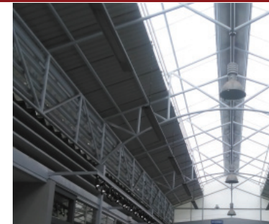
Vestíbulo principal de la Escuela de Arte y Comunicación Visual Fuente: Garita Román, M. (2018)
