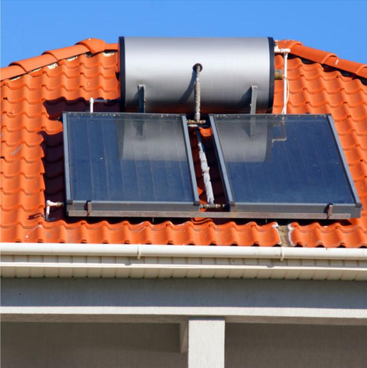
*Ilustración 21: Calentador de agua térmico. Fuente: solar-energía.net*
