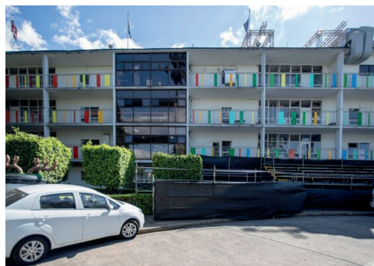
Imagen 184. Fachada actual, en proceso (2018) Fuente: La Nación
