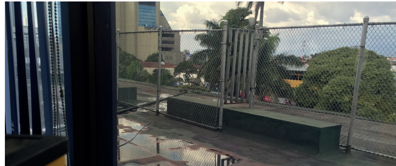
Imagen 31. Hacia las ventanas se encuentra un espacio externa no muy alentadora por su condición de desuso y poco mantenimiento.(2016) Fuente: Zheng Yang, K.
