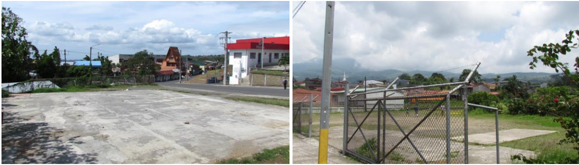
Ilustración 92. Vista norte y sur después de la Quebrada San Isidro desde Avenida 2. Hidalgo, R. (2018)
