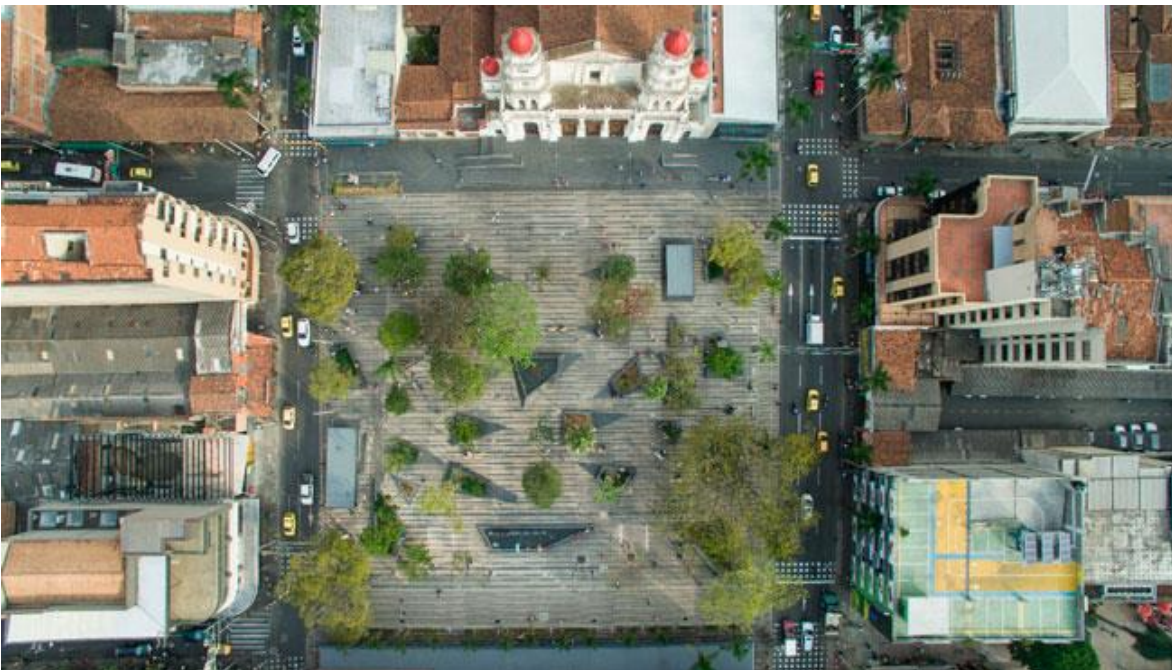
Ilustración 69. Vista de conjunto del Parque de Envigado. Recuperado de: http://www.optima.com.co
