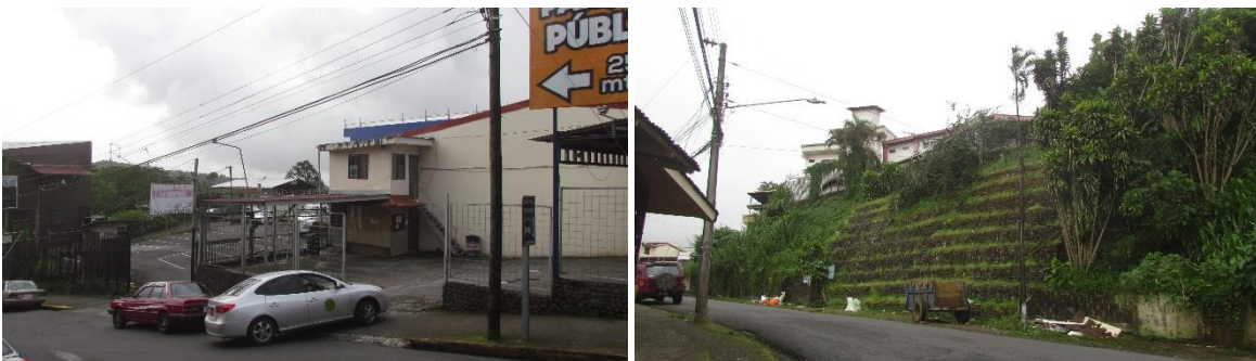
Ilustración 95. Parada de taxis y parqueo privado en Avenida Central, costado noroeste del parque. Muro de contención de piedra galvanizada en Barrio La Cruz. Hidalgo, R. (2018)
