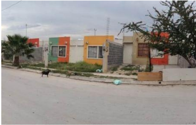
Ilustración 14 Colonia Real San Felipe. García, N. (2016). Recuperado de: https://lasillarota.com/estados/mini-casas-fraude-constructora-nuevo-leon-/107318
